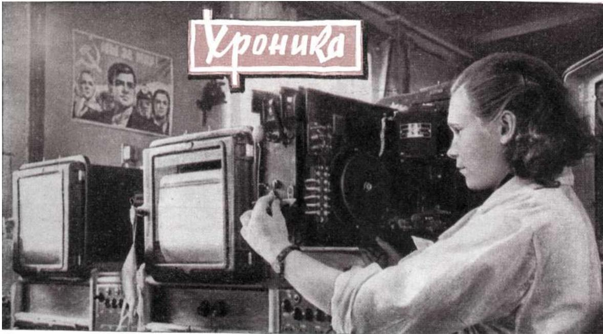
ЛЕНИНГРАДСКИЙ завод «Свобода» изготовил партии электронных приборов, которые измеряют, записывают и автоматически регулируют температуру технологических процессов. Эти приборы
